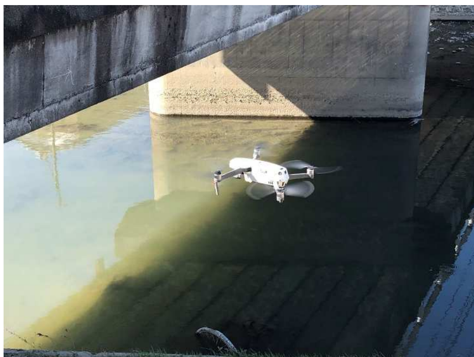
写真2 ドローン点検状況
